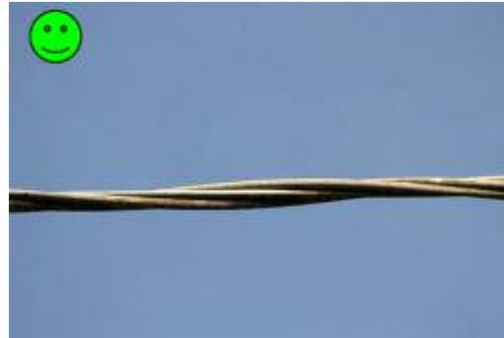
Il cavo Elicord è un cavo composto da tre singoli cavi elettrici isolati tra loro e arrotolati ad elica attorno ad una fune portante, capace di sostenere il peso dell'intera struttura da traliccio a traliccio. Se la visibilità dell'Elicord garantisce maggiormente la sicurezza per l'avifauna, l'isolamento elettrico dei suoi cavi è efficace per gli addetti
